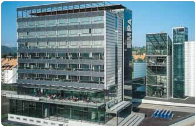
Obr. 4 Administratívna budova v Sankt Gallene
